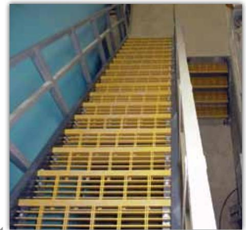
L'escalier du dessus, doté de marches moulées Fibertred, permet d'accéder au réservoir d'une station de pompage.
