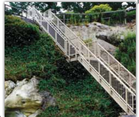
Cet escalier entièrement en PRF est situé dans une résidence privée de la communauté de Pebble Beach en Californie. L'escalier mène de la cour avant de la maison à la plage privée attenante.
